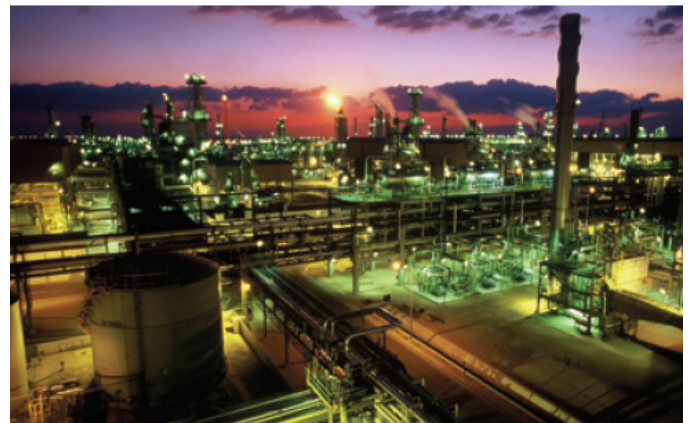
RasGas LNG facility in Qatar
